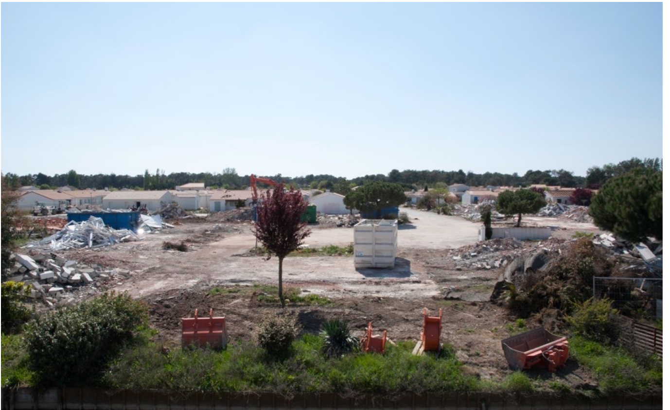
La Faute-sur-Mer, Lotissement des voiliers, Xynthia + deux ans : déconstruction des maisons (2012)
