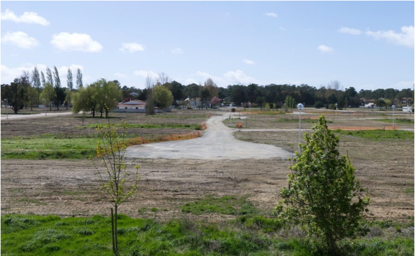
La Faute-sur-Mer, Lotissement des voiliers, Xynthia + trois ans : fin de déconstruction des maisons (2013)
