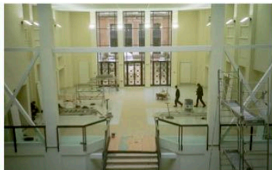
Atrium central (travaux en cours, 2002)
