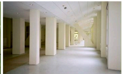
Salle des pas perdus (travaux en cours, 2002)
