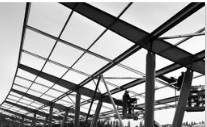
Réalisation de l'ombrière (2011)
