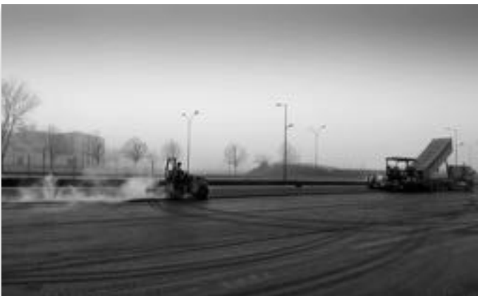
Enrobage de la plateforme (2010)
