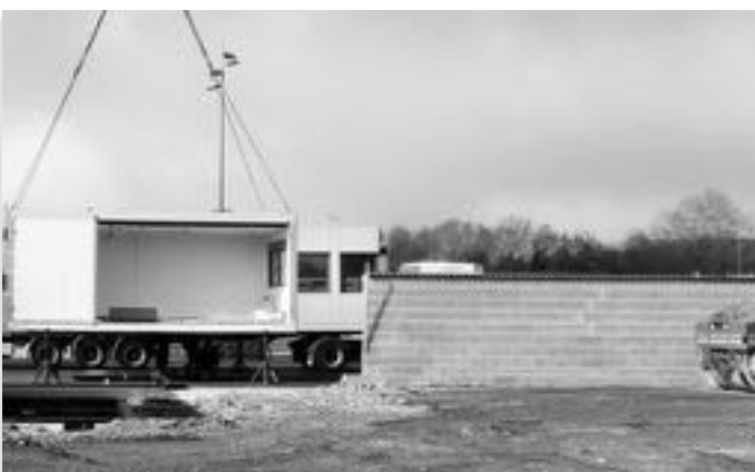
Pose des bâtiments modulaires (2011)
