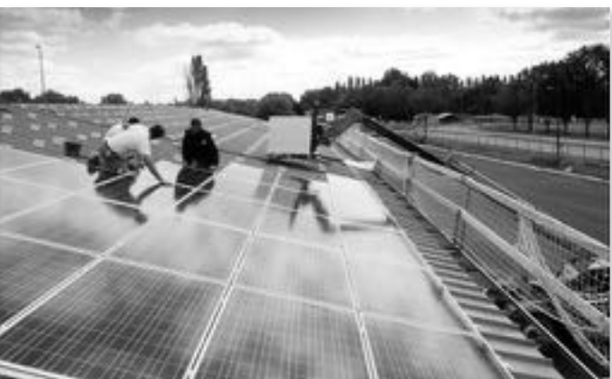
Pose des panneaux photovoltaïques (2011)
