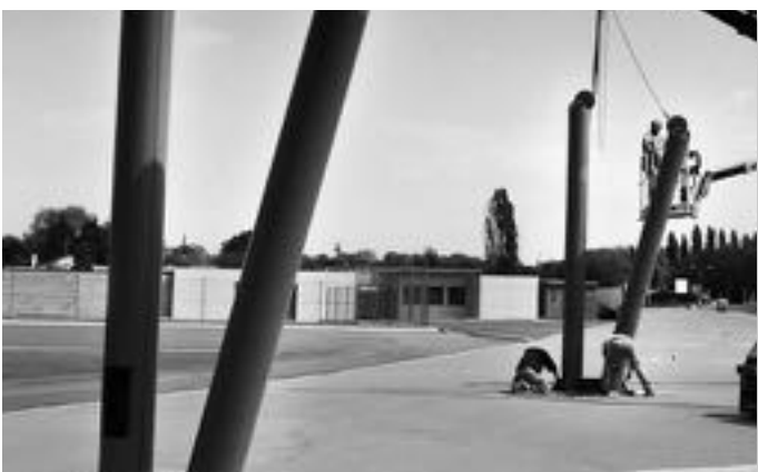
Pose des poteaux de l'ombrière (2011)
