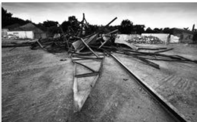
Déconstruction des bâtiments existants (2010)
