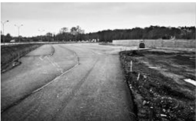
Préparation de la plateforme (2010)
