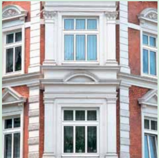
Präzise gearbeitete Sprossenverbindungen und Zierprofile sind für stilvolle Renovierungen zur Erhaltung des ursprünglichen Charakters unverzichtbar.
